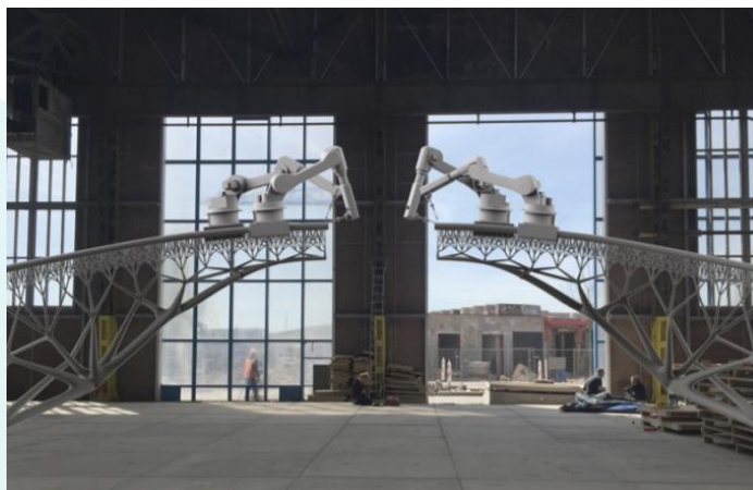
Figura 22: Ponte por Impressão 3D[59].
